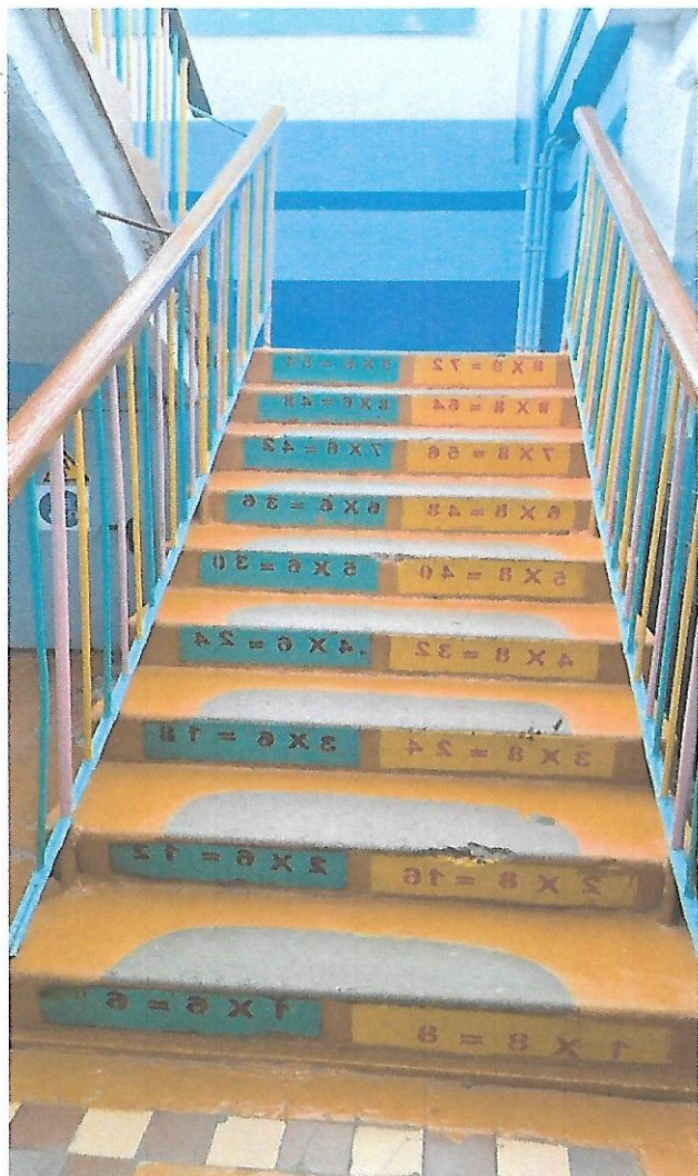
Ф.10 Лестница внутри здания МБОУ «Юлдусская СОШ им. Х.Г. Гизатуллина»
